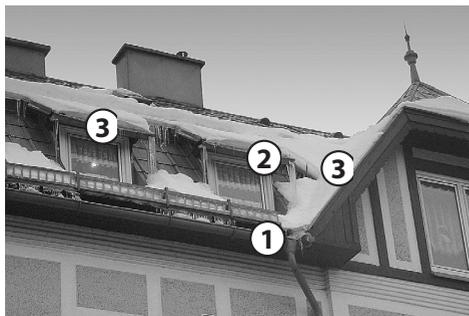
**La sonde n° 1** est placée dans une partie ombragée de la façade. C'est la plus importante car toute l'eau de fonte passe par cette sonde, jusqu'à ce que la gouttière soit sèche. Comme la neige a tendance à glisser vers cet endroit, l'emplacement est l'un des derniers à sécher.
